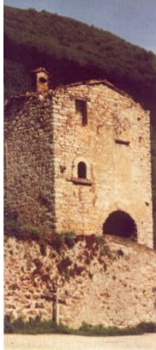
Case e palazzetti in attesa di .... restauro. Ne varrebbe la pena!
